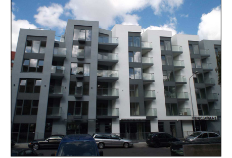
BUDYNEK MIESZKALNY WIELORODZINNY Z USŁUGAMI W PARTERZE Z GARAZEM PODZIEMNYM PRZY ULICY WENECJAŃSKIEJ 8 W POZNANIU
